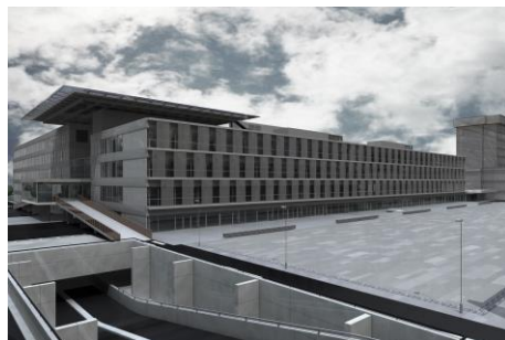
Ampliamento Ospedale San Maurizio, Bolzano
